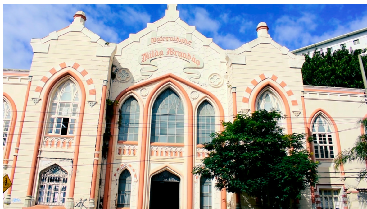
Figura 6: Prédio que abriga a Provedoria da Santa Casa BH – antiga Maternidade Hilda Brandão
